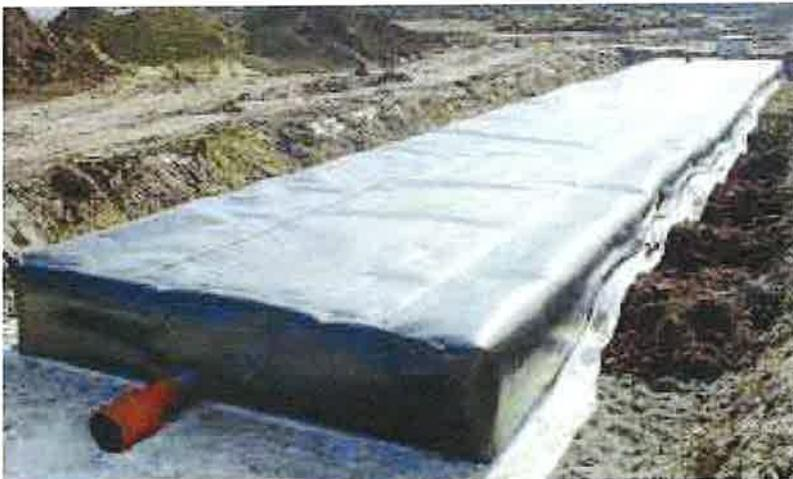
*Bild 3: Beispiel Verschweißte Rückhalteeinrichtung aus Speicherboxen mit Reinigungskanal*
