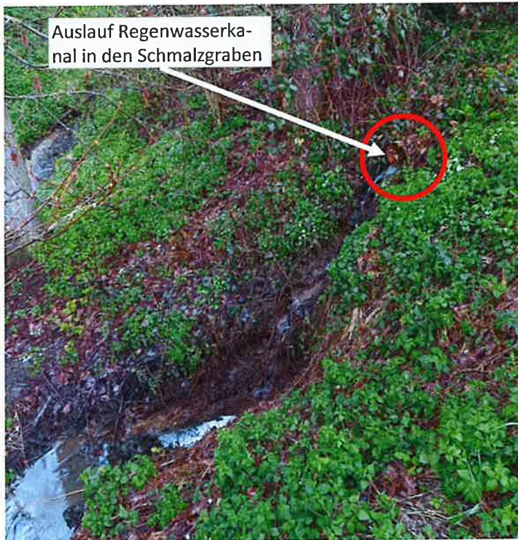
Abbildung 1: Einleitungsstelle A I in den Schmalzgraben
