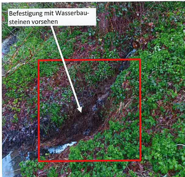
Abbildung 14: Geplante Maßnahme bei Einleitungsstelle A I
